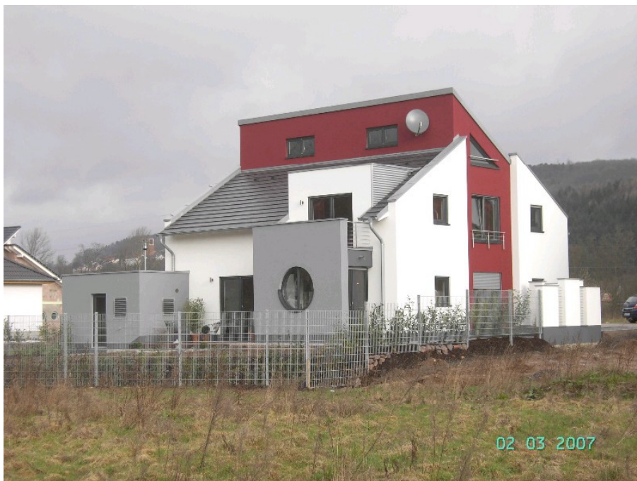
Bild 4: Ansicht hinten rechts
